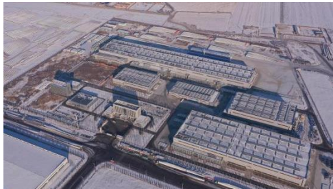
松原新能源装备产业园分布式光伏发电项目
