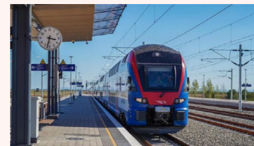
匈塞铁路塞尔维亚诺苏段列车运行
