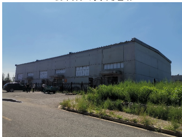
一期危险废物暂存库
